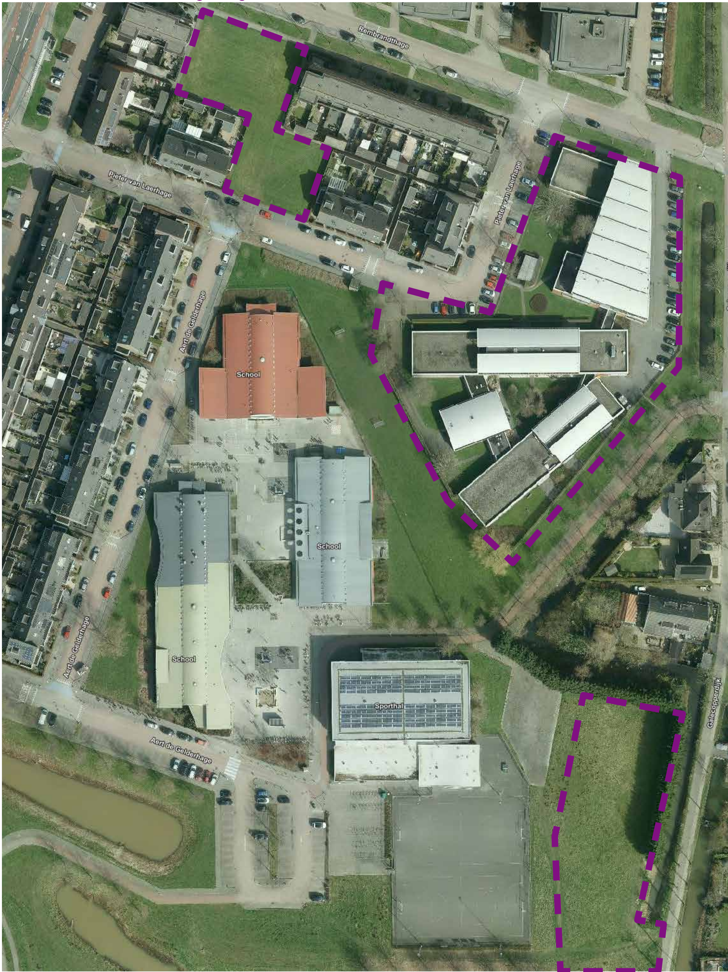
Luchtfoto bestaande omgeving
